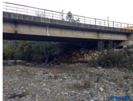
Photo 1 : Situation du pont de mosquée (RR508).
