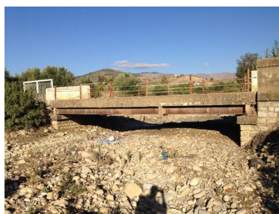
Photo 4 : Situation du Pont reliant Had Msila et la ville de Taza (RR508).
