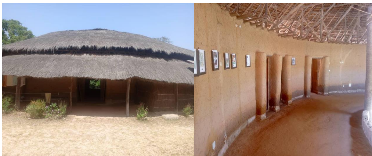
Figure 2 : Le campement solidaire de Séléki construit en architecture locale
