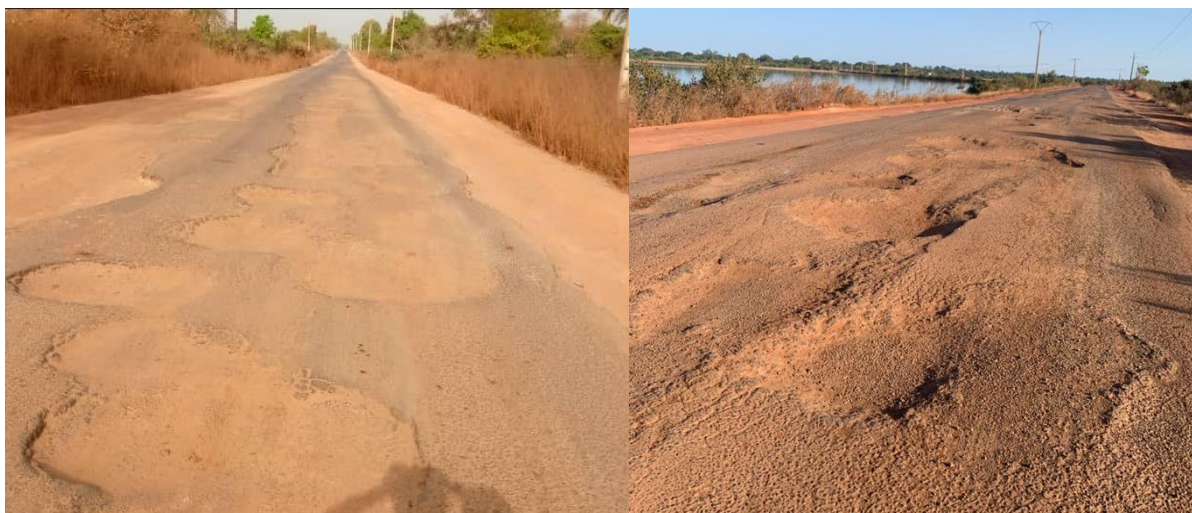
Planche de photos 1 : État de dégradation de la route nationale 5 (auteurs, février 2025).
